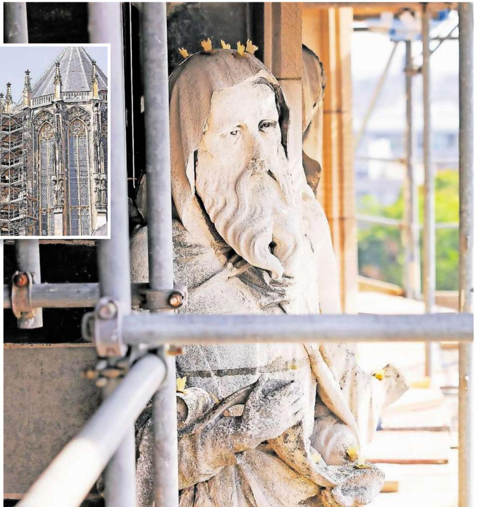
Wind und Wetter setzen dem Aachener Dom zu: Im Rahmen der Sanierungsarbeiten an der Chorhalle werden auch die Figuren an der Fassade von Expertenhand gesäubert. An der Chorhalle des Münsters (kl. Foto) müssen unter anderem Fugen und Steine ausgetauscht werden. FOTOS: ANDREAS STEINDL
